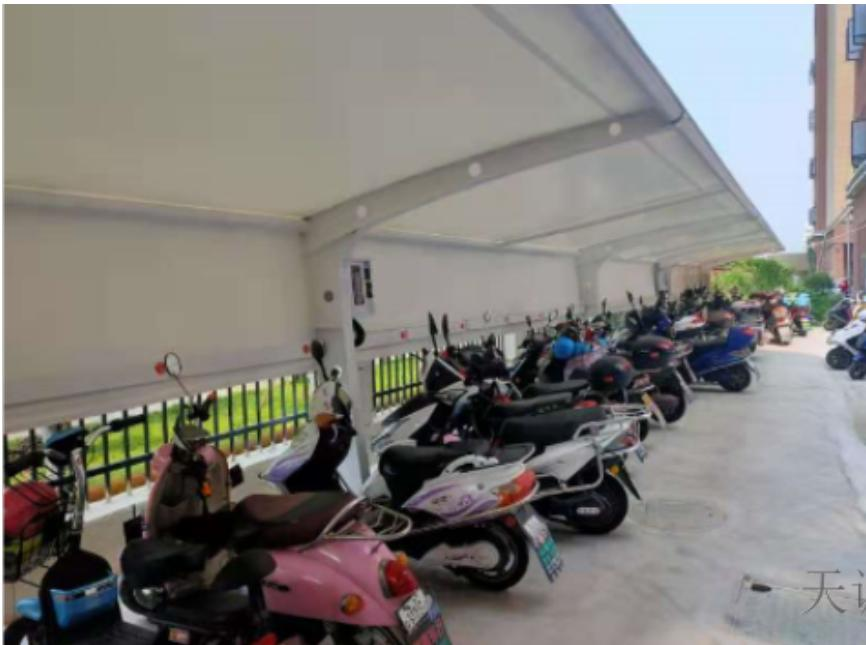
对于户外/室外的东西，它们是要经历风吹雨打的，因此，为了很好的保护户外/室外膜结构停车棚，我们应该将户外/室外膜结构停车棚膜面定期清理；避免灰尘或杂物的堆积太久影响美观且降低使用周期。原材料不同价格自然也不同，有实力的厂家都会有长期的原材料合作商，且批量拿货，因此其所拿到的原材料价格自然要比小厂家便宜好多！膜结构停车棚采用的主要是PVDF材料，而影响PVDF材料价格的因素有厚度。一般要视膜结构停车棚功能来决定其需要使用哪种厚度的材料进行生产。
